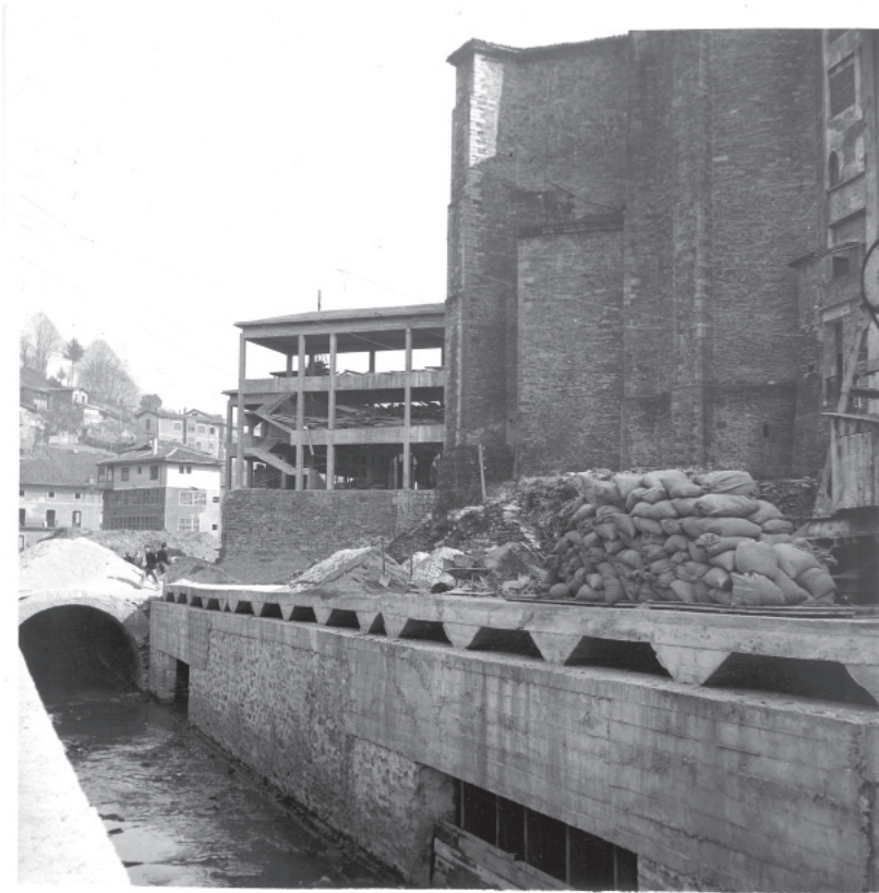
27. irudia. Ego ibaiaren estaltze- eta kanalizazio-lanak San Andres parrokiaren inguruan. Eibarko Udal Artxiboa. Hirigintza eta Obrak Argazki Funtsa. Sig. 13.041. HIF.
