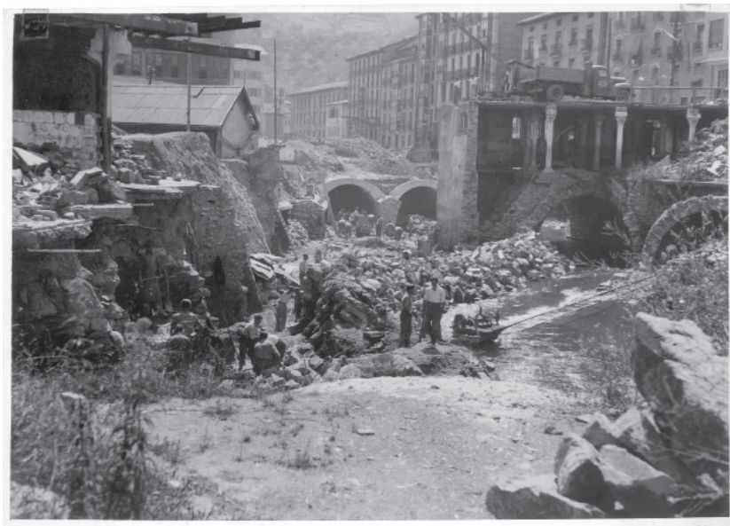
25. irudia. Ego ibaiaren estaltze- eta kanalizazio-lanak merkatu zaharraren inguruan. Eibarko Udal Artxiboa. Hirigintza eta Obrak Argazki Funtsa. Sig. 14.036. HIF.
